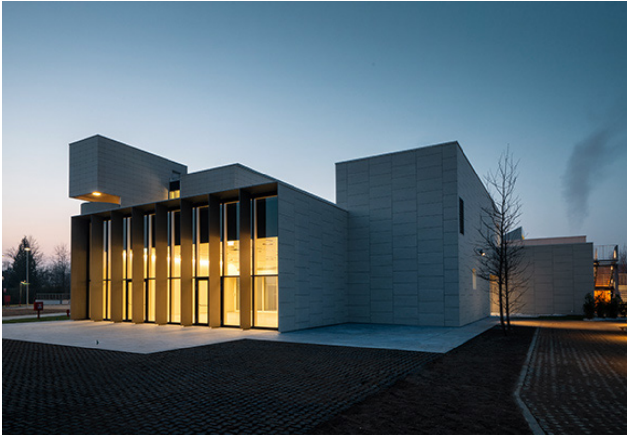
Ampliamento Humanitas, Rozzano (MI)
