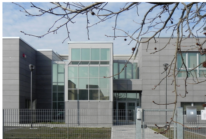
Palazzina uffici, Arre (PD)
