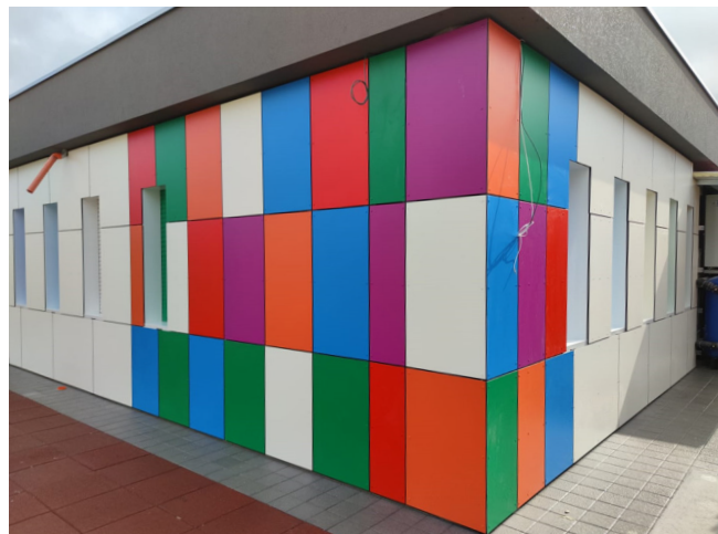
Edificio scolastico, Torrenova (ME)
